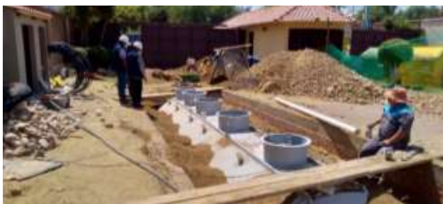
Fotografía 10: Construcción de un sistema de tratamiento de aguas residuales domésticas (STARD) para 150 personas, aprox.
